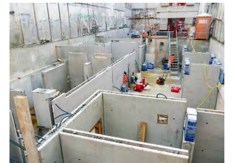
Site sur rue commerçante à l'aplomb d'un tunnel du métro L13 Mise en œuvre de boîtes-à-ressort
