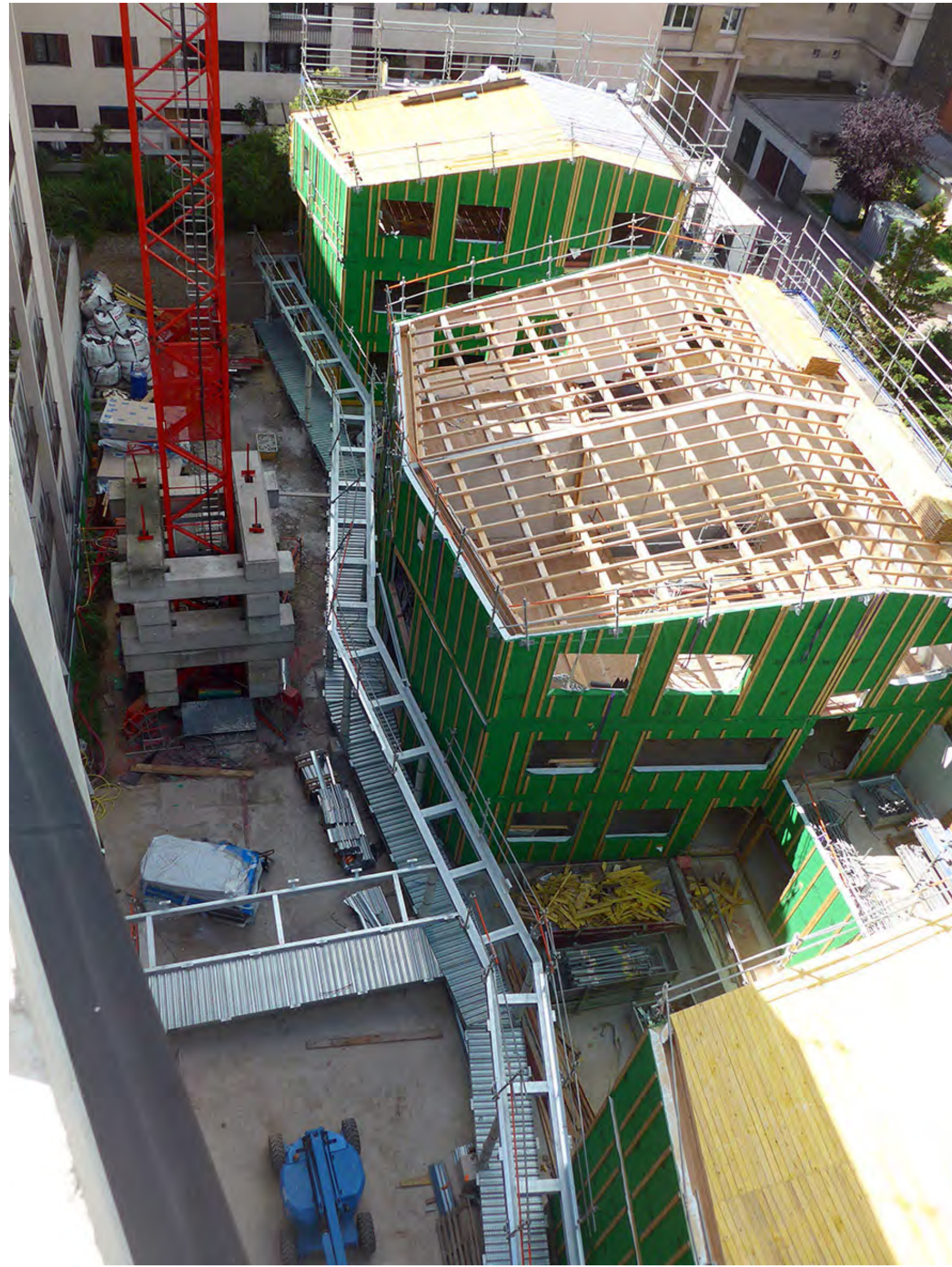
Maisonnées et coursives en cours de réalisation
