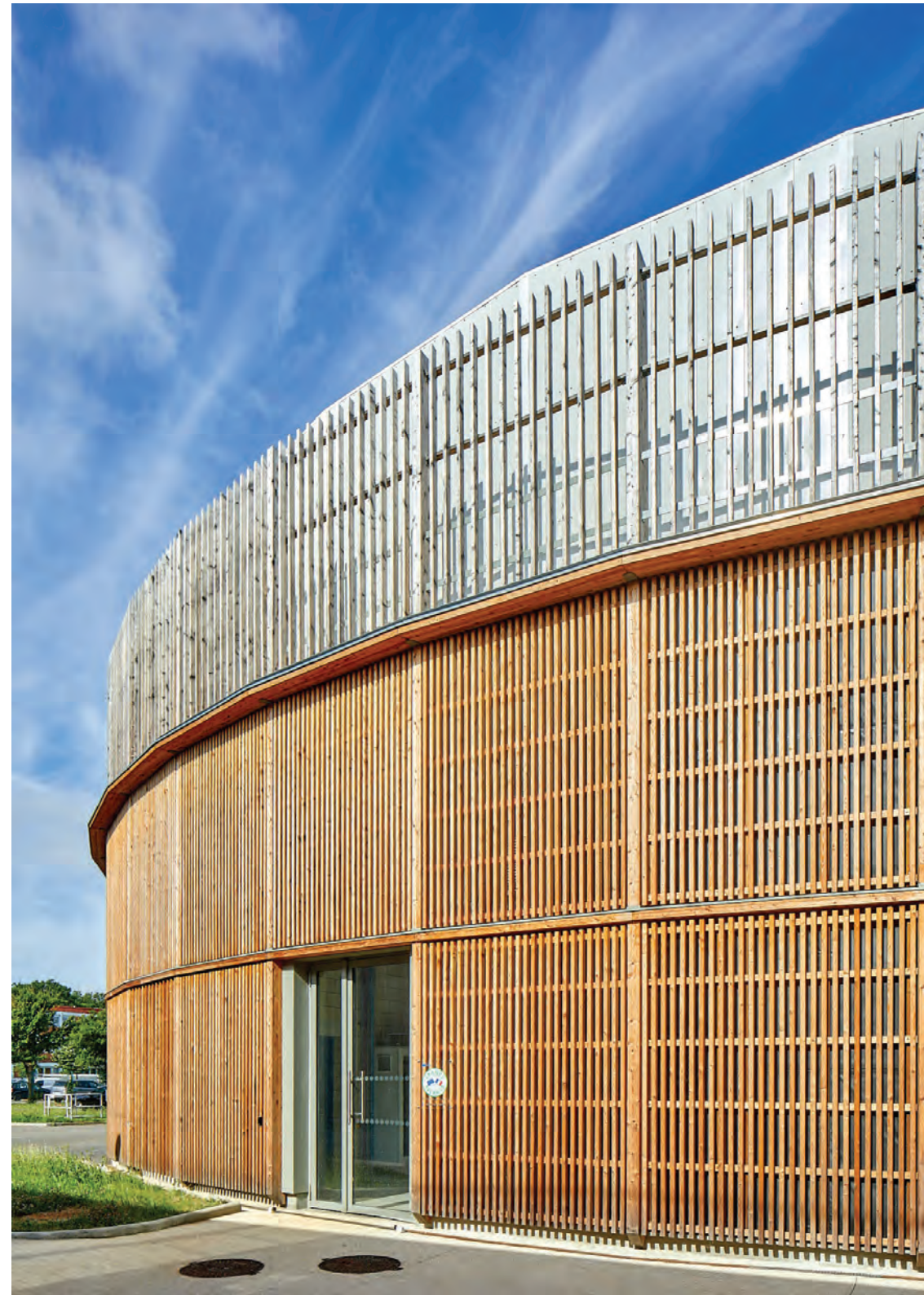
Entrée de service du bâtiment
