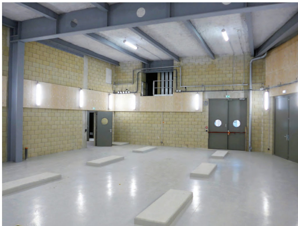
Salle des groupes froids avant l'installation du matériel.
