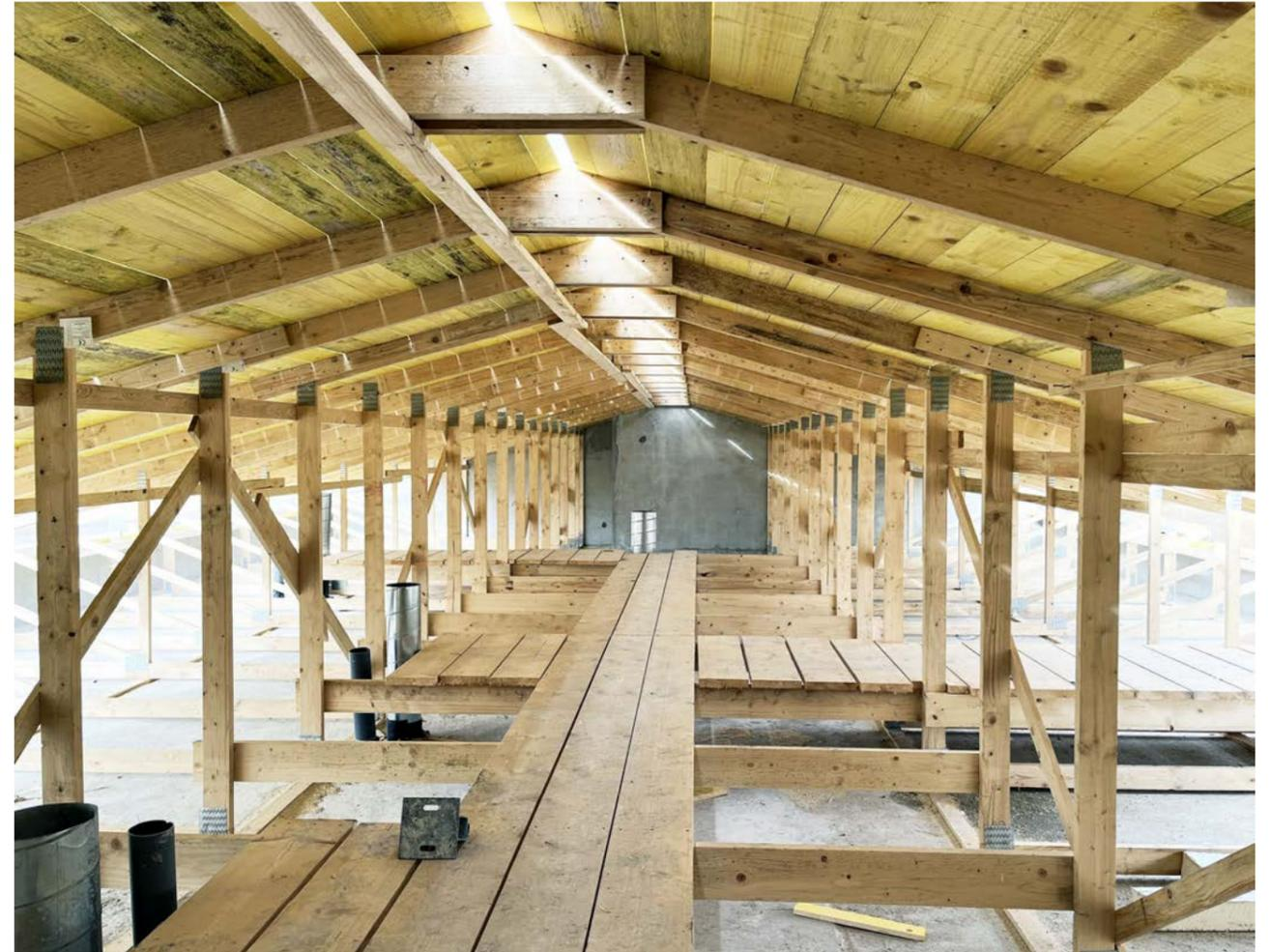
Charpente des toitures du lot B2 avec cheminement technique d'entretien en platelage
