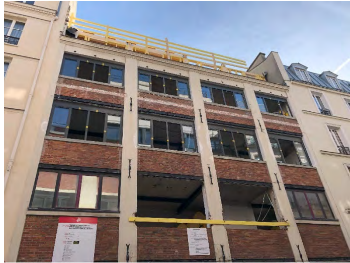
Curage du bâtiment existant, renforcement des structures et mise à niveau des allèges des fenêtres
