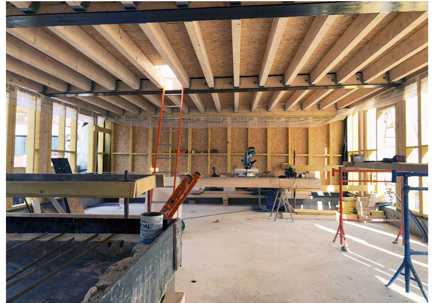
Réalisation de la surélévation en ossature bois – structure mixte acier/bois
