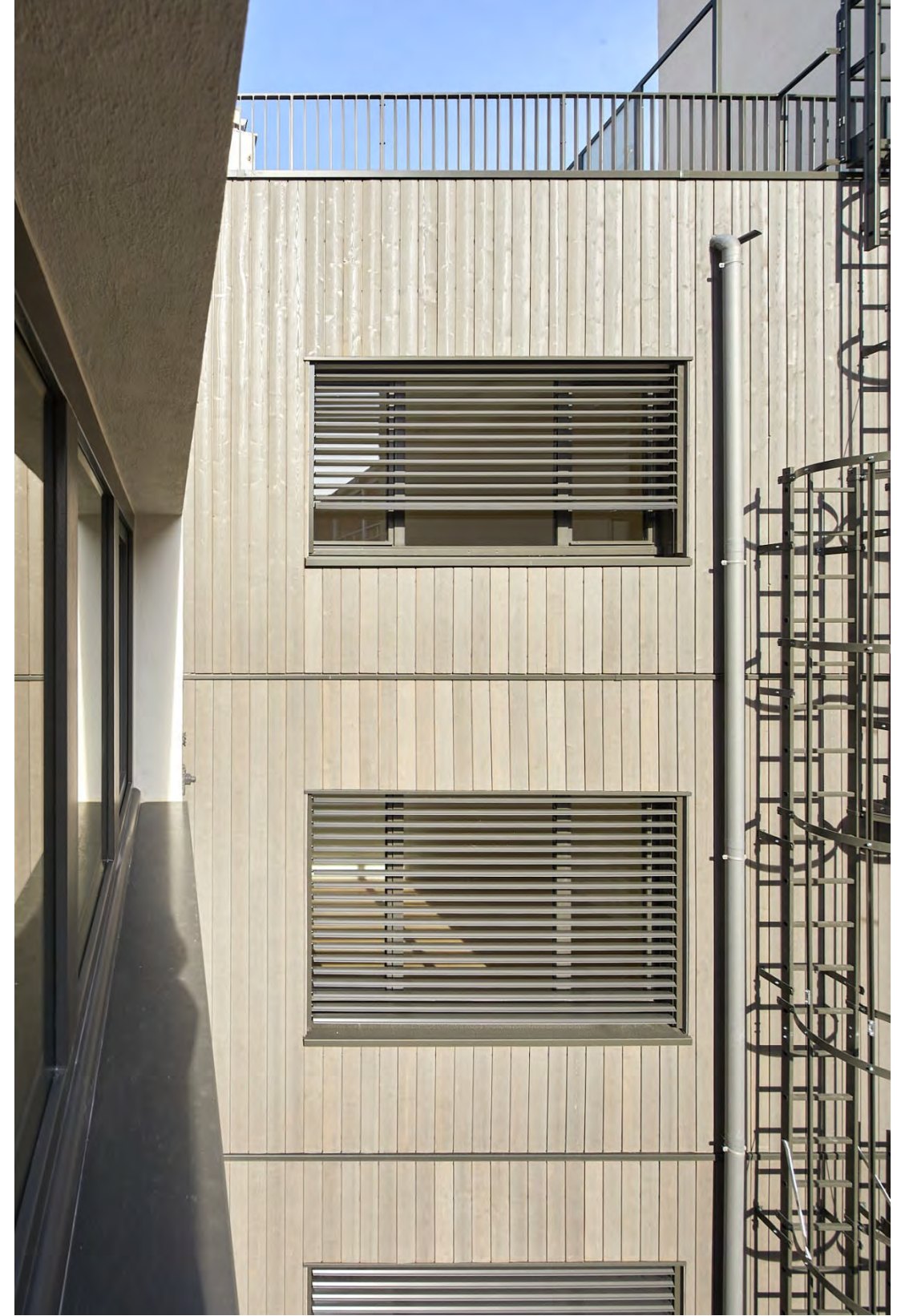
Occultation par stores métalliques à lames orientables motorisés (rue et cour)
