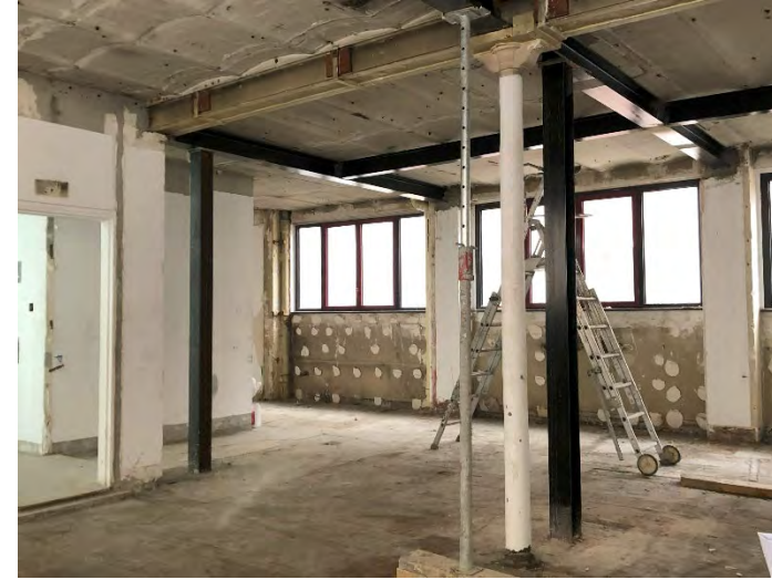
Curage du bâtiment existant, renforcement des structures et mise à niveau des allèges des fenêtres
