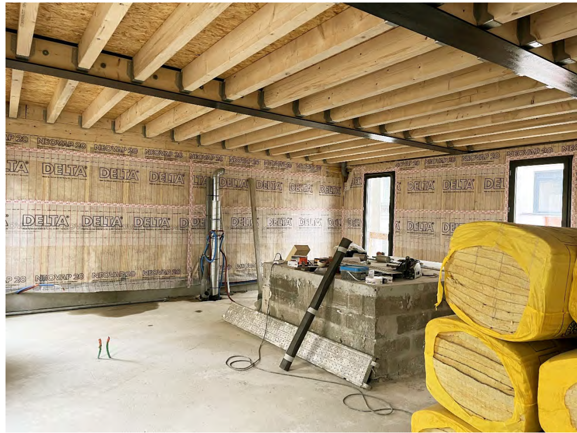
Réalisation de la surélévation et de l'extension en ossature bois
