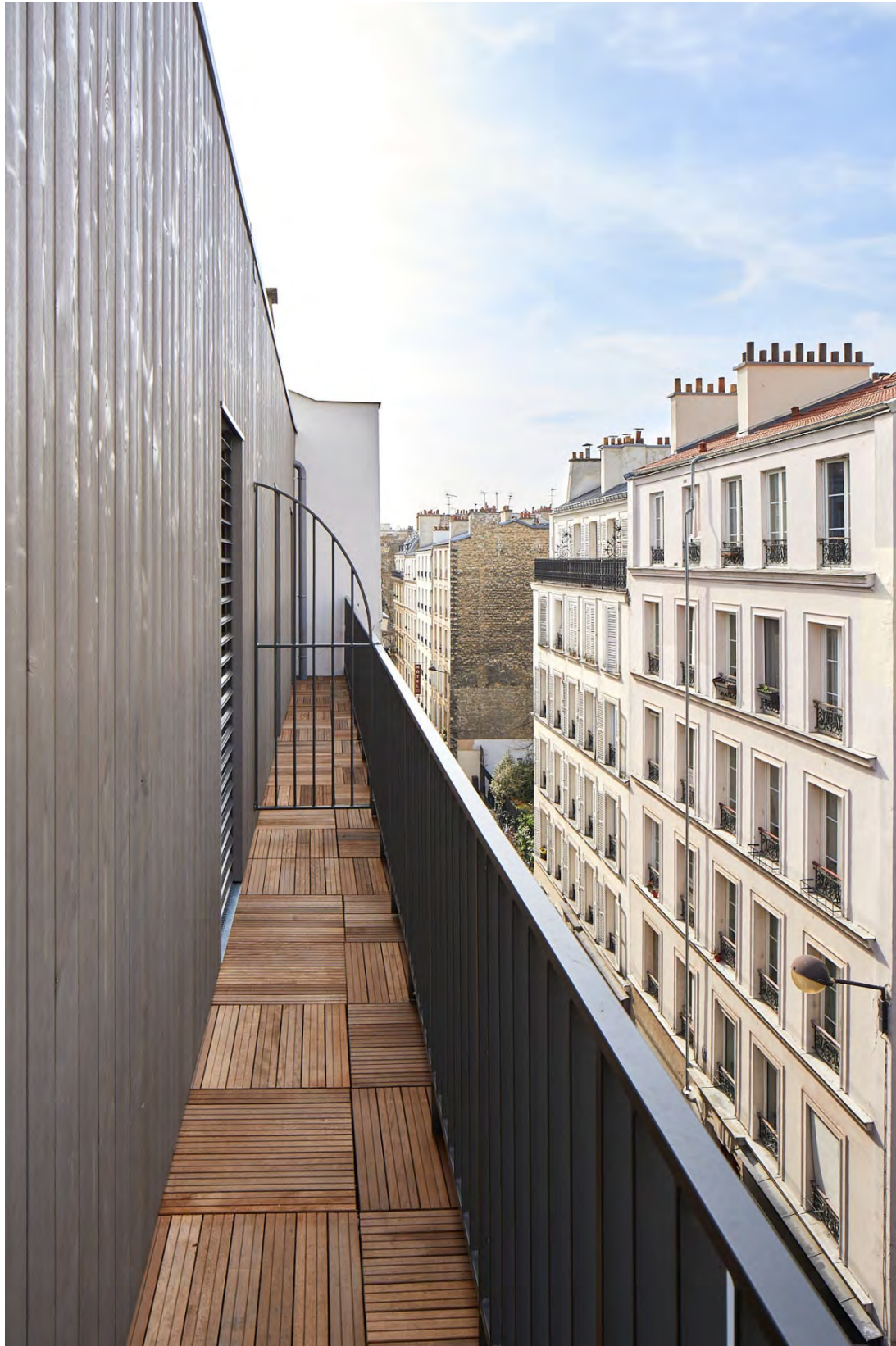
La surélévation et l'extension en MOB sont habillées en bardage bois
